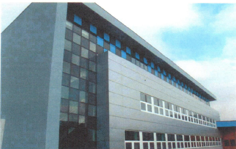
HET NIEUWE GEBOUW IS BIJNA VOLTOOID.
