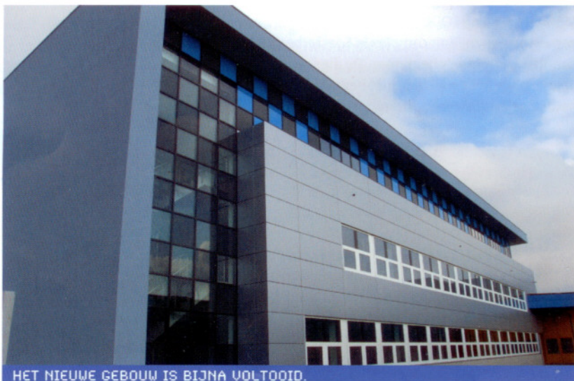
HET NIEUWE GEBOUW IS BIJNA VOLTOOID.
